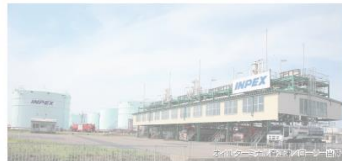
オイルターミナル直江津のオイルタンク
